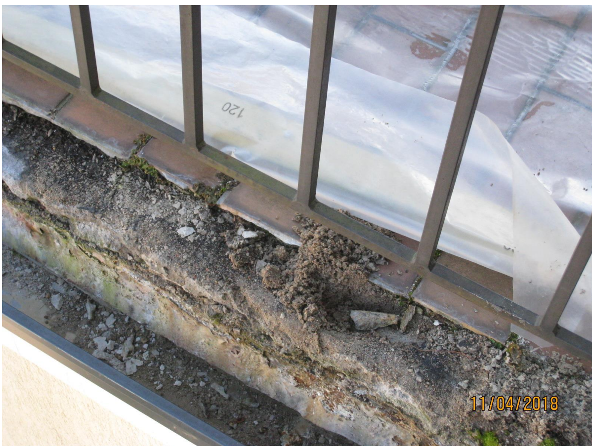
Pašalinus karnizo plyteles, matoma, kad po cementiniu sluoksniu nėra ruloninių hidroizoliacinių sluoksnių (žr. nuotrauka Nr. 5).
