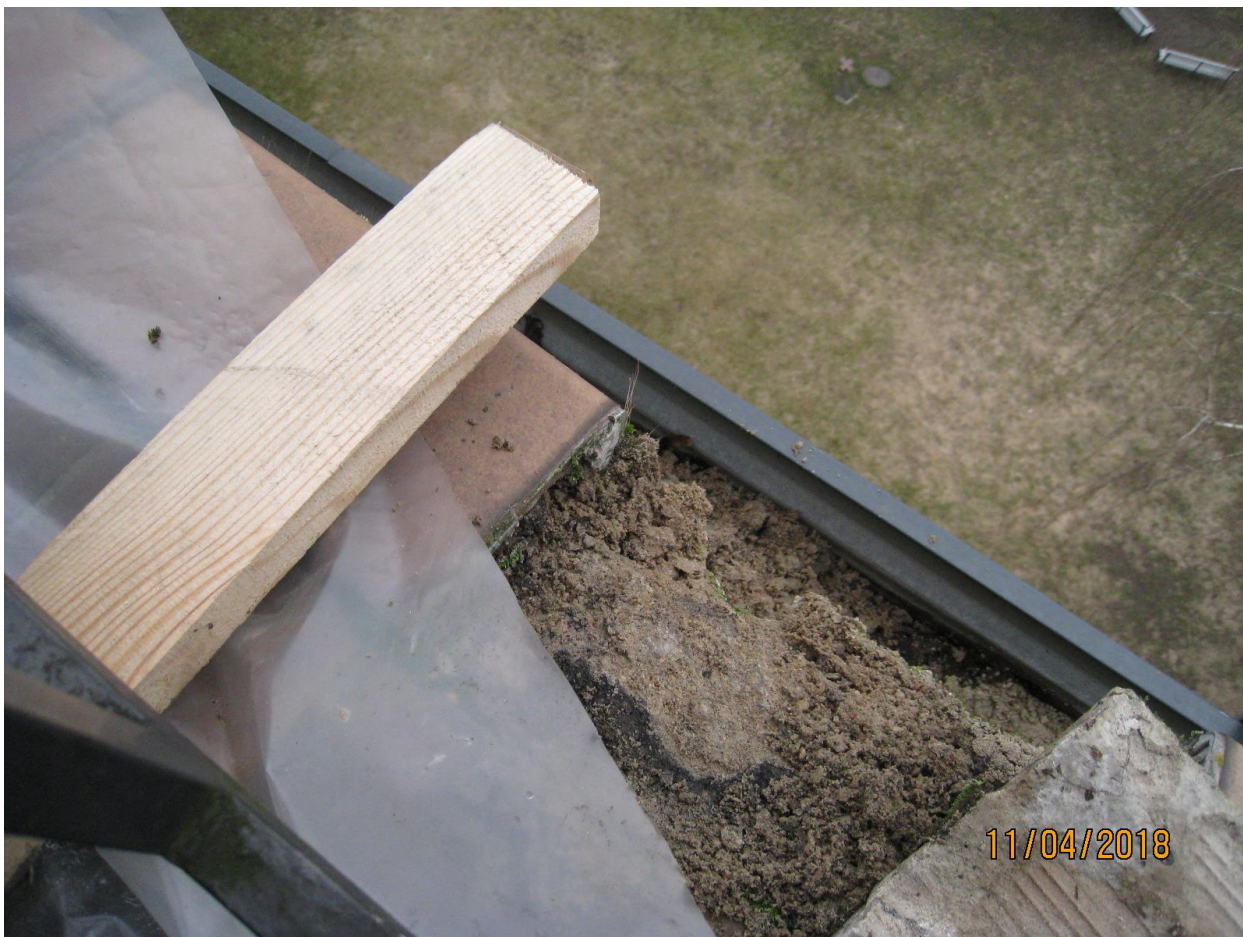
Pašalinus karnizo plyteles, matoma, kad po cementiniu sluoksniu nėra ruloninių hidroizoliacinių sluoksnių (žr. nuotrauka Nr. 5).
